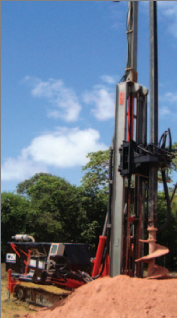
Perfuração com trado mecânico e haste telescópica Drilling with auger and kelly bars
